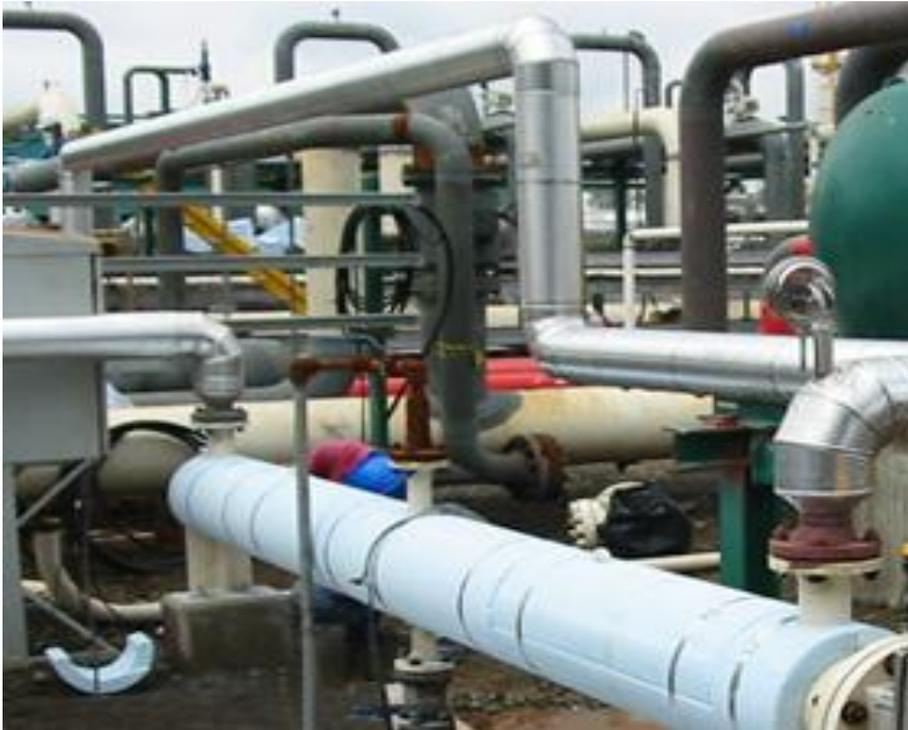
*Verifique en un día de lluvia, el incremento en la producción de energía necesaria para eliminar el agua que absorbe la aislación de Silicato de Calcio, esta no recupera su capacidad aislante luego de la eliminación del vapor.*
